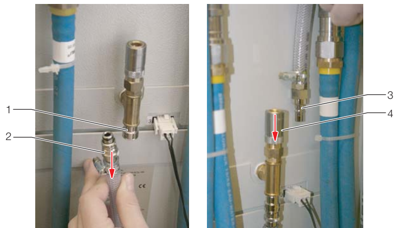
Abb. 32: Schnellkupplung am Kondensatablauf
